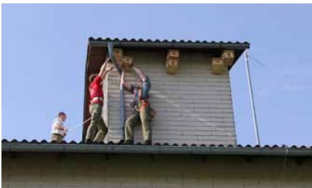
Montage der neuen Kästen beim Feuerwehrhaus Altenberg
