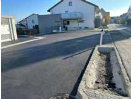
Parkplatz beim Trafogebäude
